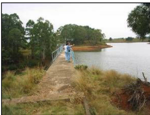
Vista da barragem de acumulação de água no arroio da Chácara
