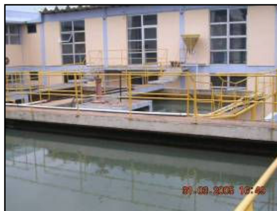
Vista da Casa de Química e Filtros do Bloco Hidráulico de Vacaria
