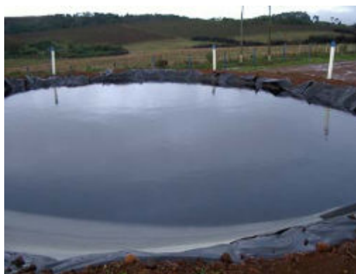
Figura 18 – Tratamento de efluentes percolados do aterro sanitário
