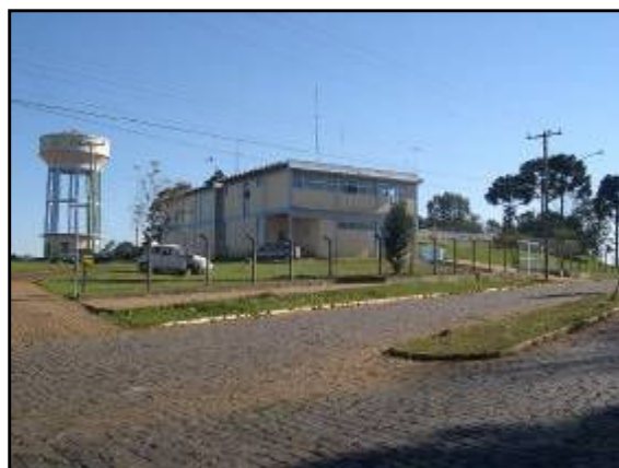
Vista da geral da Estação de Tratamento de Água
