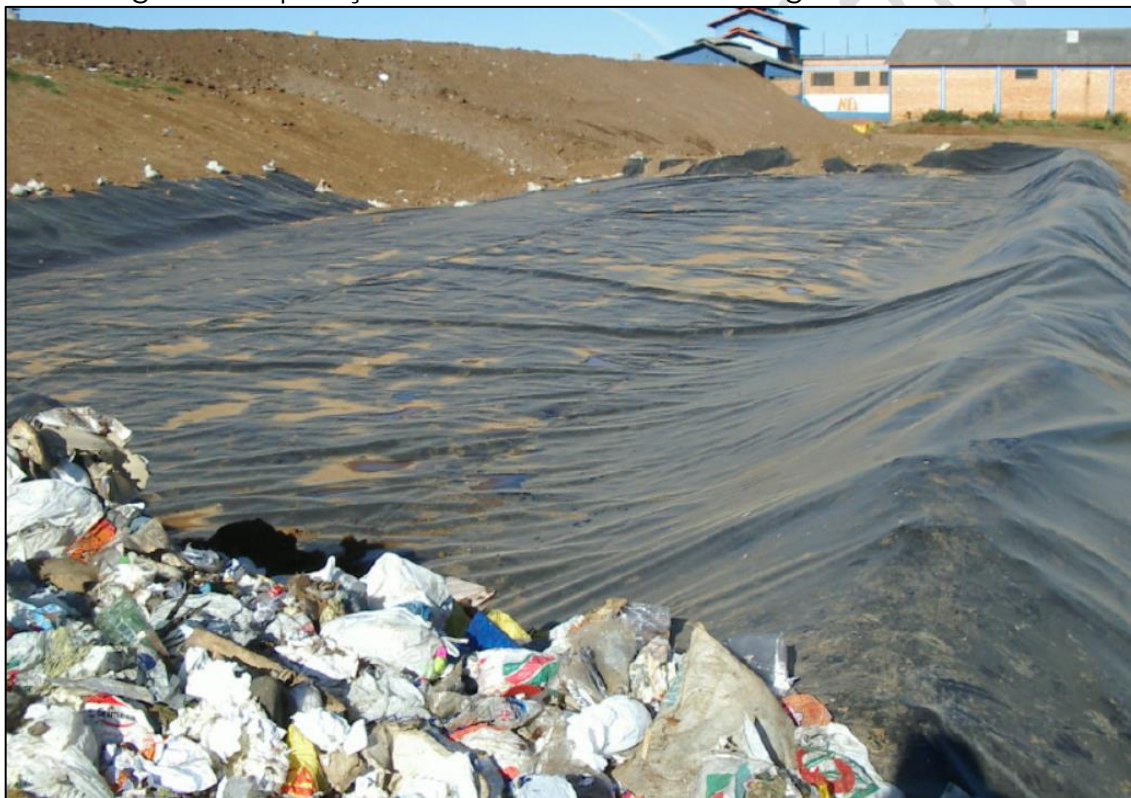
Figura 2 - Operação do Aterro sanitário na antiga célula do lixão
