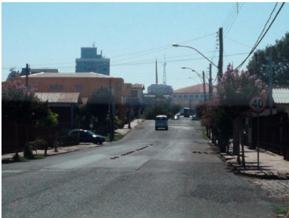
VC 044 Sentido Bairro-Centro
