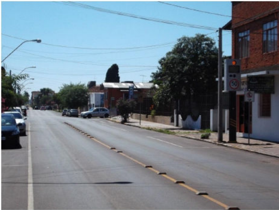
VC 059 sentido Bairro/Centro
